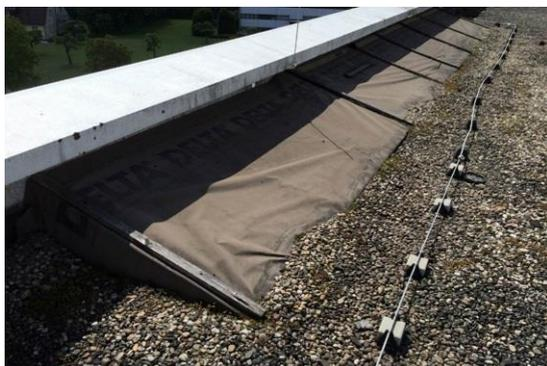
Vorhandene, schon ältere Reparaturstellen der Dachabdichtung
