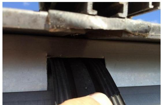
Große Undichtigkeit an der Hülle der Dachverglasung über Innenhof
