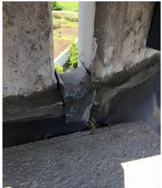
Nicht instandgesetzte Verfugungen am Dachrand (potenziell undicht)
