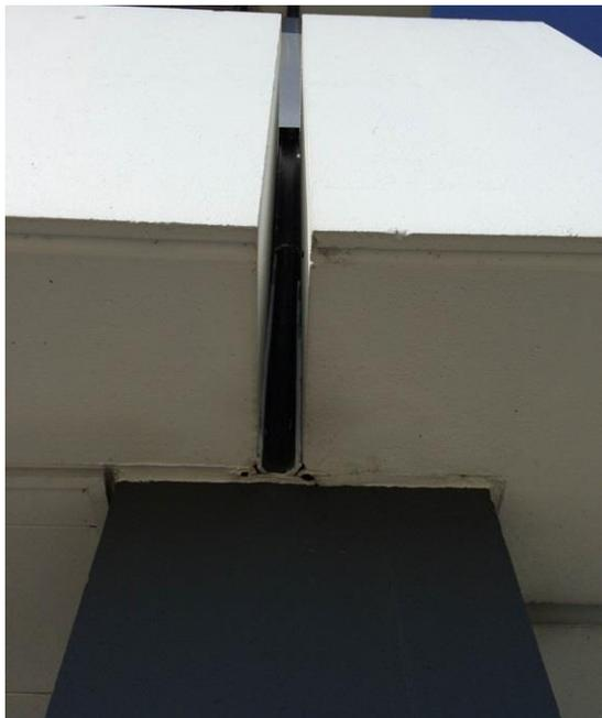
Fugenabdichtung der Betonfertigteile mit eingelegten Dichtprofilen
