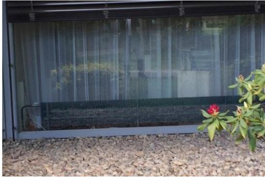
Heizkörper unmittelbar vor schwach gedämmten Verglasungen
