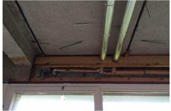
Durchstoß der Heizleitungen von innen nach außen (schwach gedämmt)
