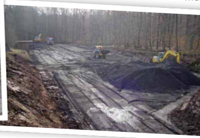
2. Der zerkleinerte Asphalt wird abtransportiert.
