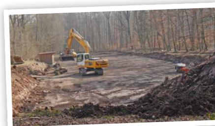
3. Frischer Mutterboden wird aufgebracht.
