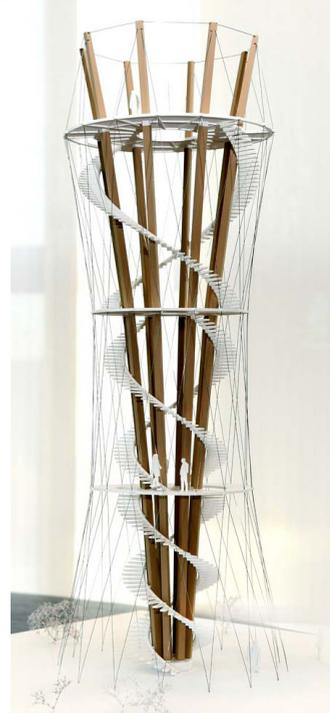
Mit einer Konstruktion aus heimischem Laubholz und gespannten Stahlseilen integriert sich der Turm optimal in seine natürliche Umgebung des Naturparks. Spiralförmig windet er sich über zwei gegenläufige Treppen nach oben bis auf 30 Meter Höhe und gibt von drei Plattformen aus einen fantastischen Blick über die Umgebung frei. Modern und leicht ist er schon zum Anschauen eine Attraktion.
