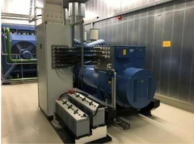
4x Notstromdieselaggregate (72 Std.) stellen die Versorgung bei Netzausfall sicher
