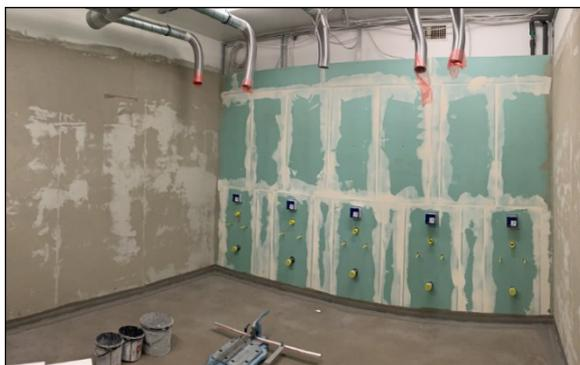
Umbauarbeiten während der Sanierungsmaßnahmen
