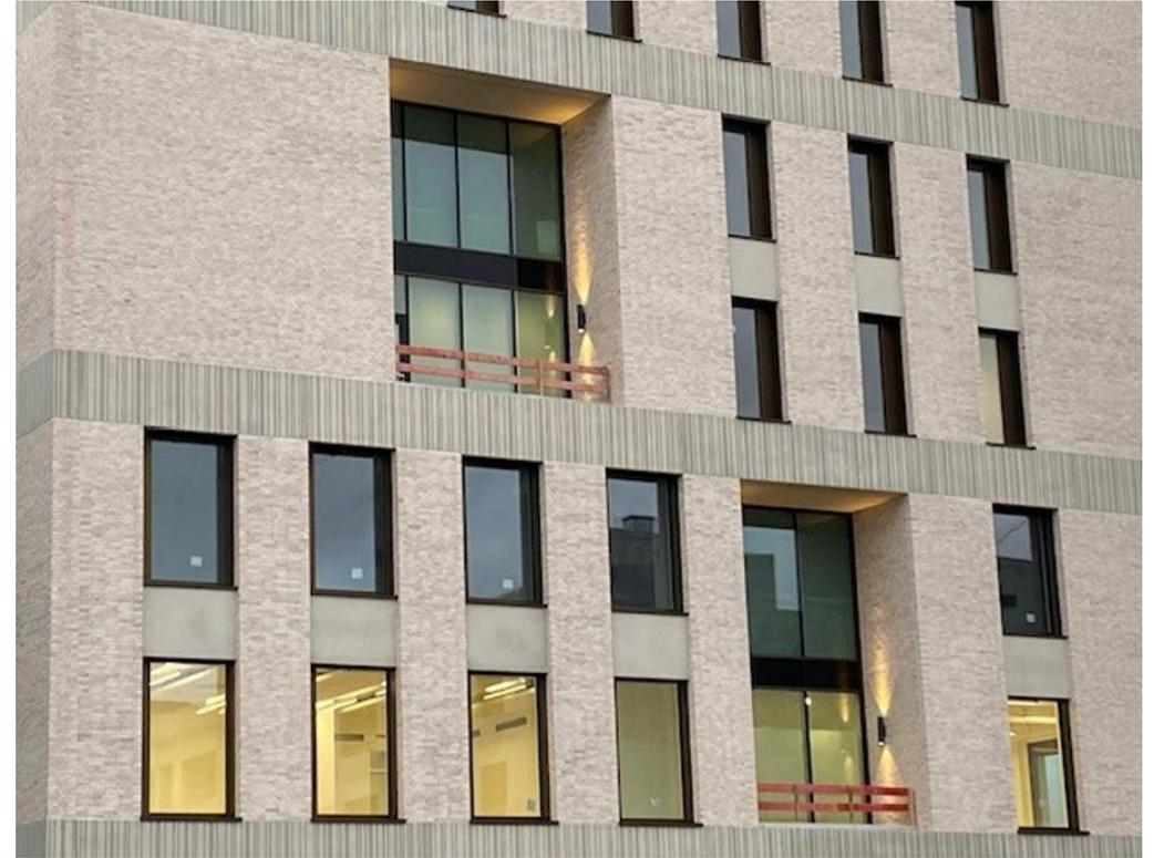
Fassade mit gemauerten Klinker und Betonfertigteilen
