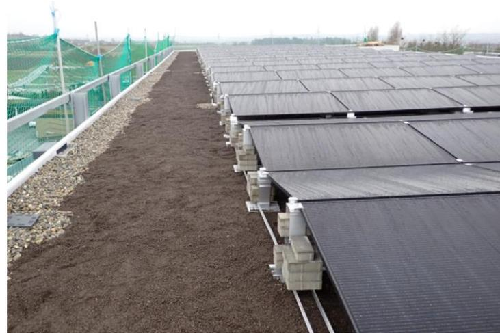
Photovoltaikanlage inkl. Dachbegrünung
